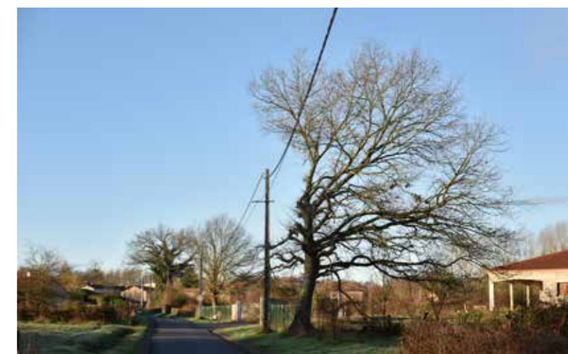
▼ Photo 2. Chantiers ENEDIS et ORANGE. Élagage pour dégager une ligne isolée en 220 V. La silhouette de l'arbre est totalement déséquilibrée. Les parties coupées n'importe comment vont repousser rapidement et de nouveau toucher les fils.
