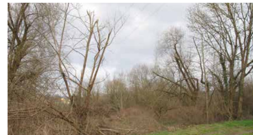
▲ Photo 1. Chantiers ENEDIS. Dégagement d'une ligne moyenne tension, coupe au lamier, les branches sont taillées en pointe, le lamier n'agissant que dans un plan vertical.
